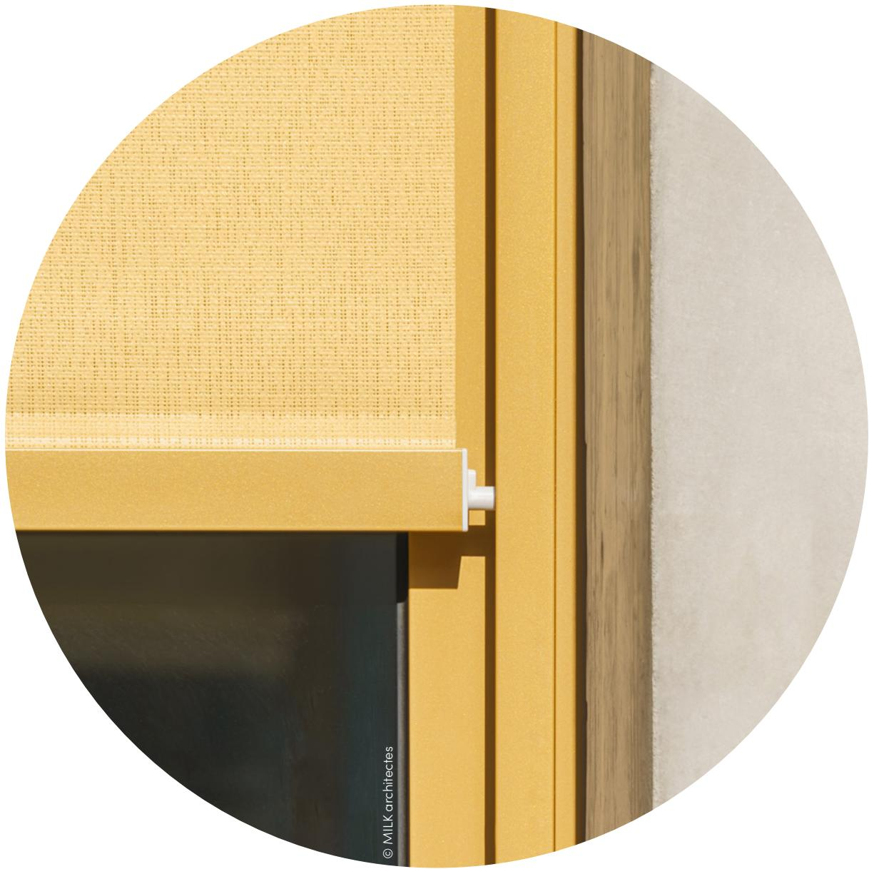
**Des lignes épurées** : le Soloscreen® 85– Ses coulisses de guidage clipées, sans vis apparentes, allient élégance et fonctionnalité.
